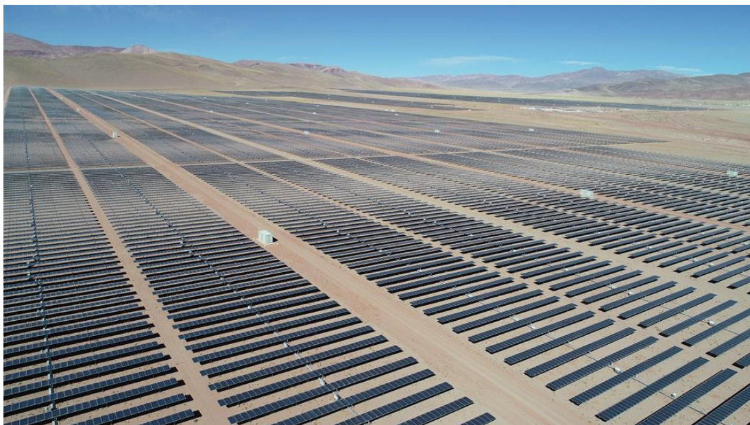
这是 2020 年 5 月 11 日拍摄的阿根廷胡胡伊省高查瑞 300 兆瓦光伏发电项目光伏发电板（无人机照片）。新华社发（上海电建阿根廷高查瑞 300 兆瓦光伏发电项目项目部供图）
